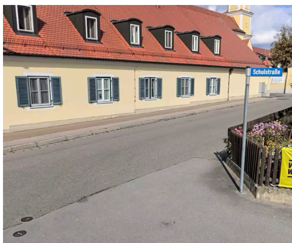
KEINE GESICHERTE, BARRIEREFREIE ÜBERQUERUNGSSTELLE (-)
