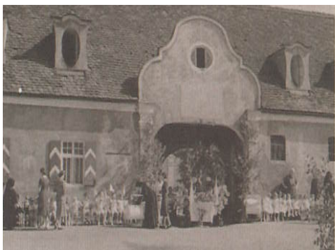
WIRTSCHAFTSTRAKT VOR DEM ABRISS
