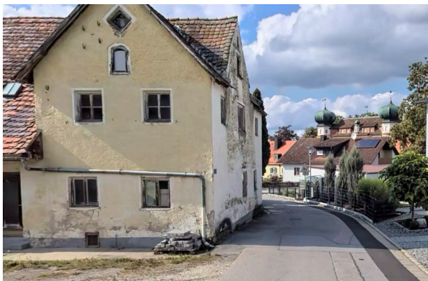
GEFÄHRLICHE KURVE, KEINE GEHWEGE (-)
