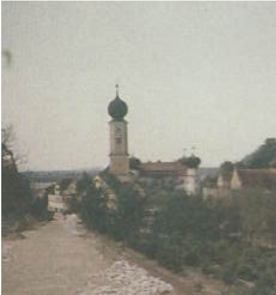
BLICK VOM SOMMERKELLER IN RICHTUNG ST. VITUS
