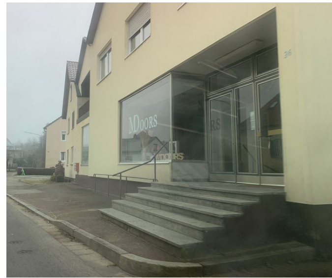
KEIN BARRIEREFREIER ZUGANG (-)
