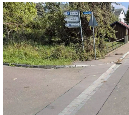
ABSENKUNG UND PFLASTERUNG AN DER HOFMARK NICHT BARRIEREFREI (-)
