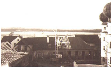
DACHSTUHL VOR DER FERTIGSTELLUNG
